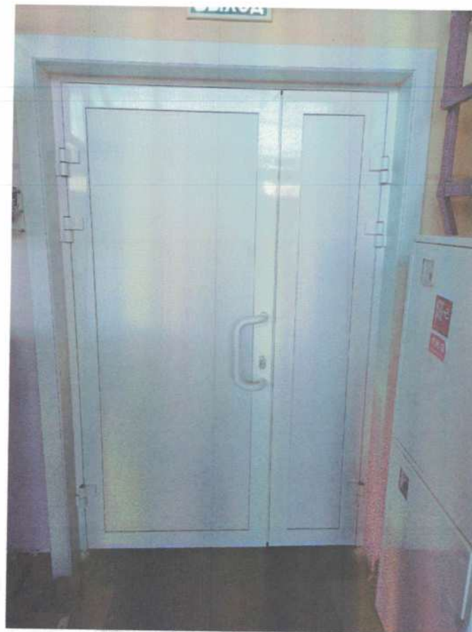
Замена дверей в раздевалке № 1 спортивного зала
